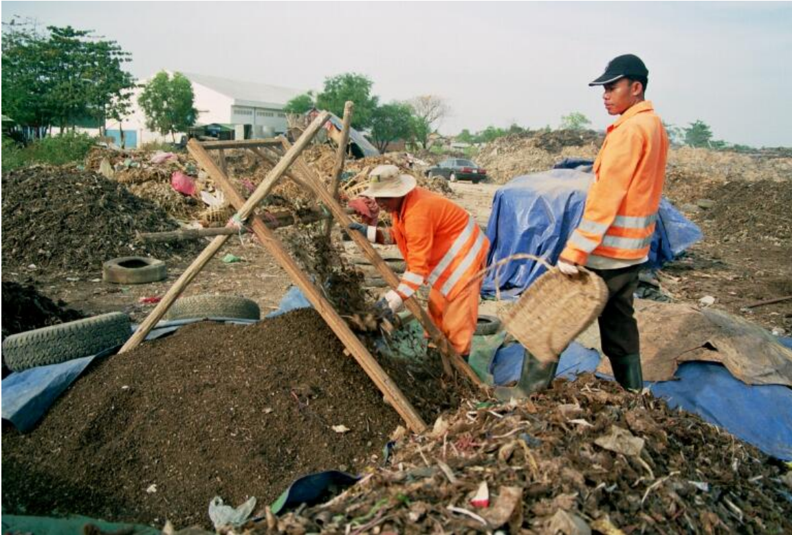
Bild 13: Manuelles Absieben von Kompost mit dem Aufstellsieb
