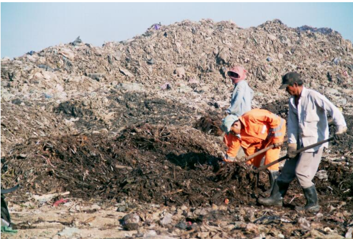
Bild 14: Umsetzen einer Rottemiete mit Mistgabeln
