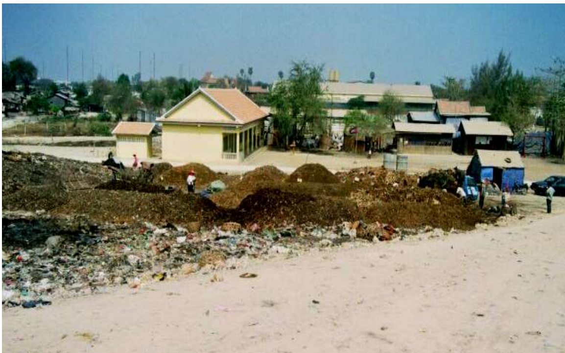
Bild 4: Pilot-Kompostierungsanlage nach den Straßenbaumaßnahmen von CAP mit Erschließungsstraße und angrenzender Schule
